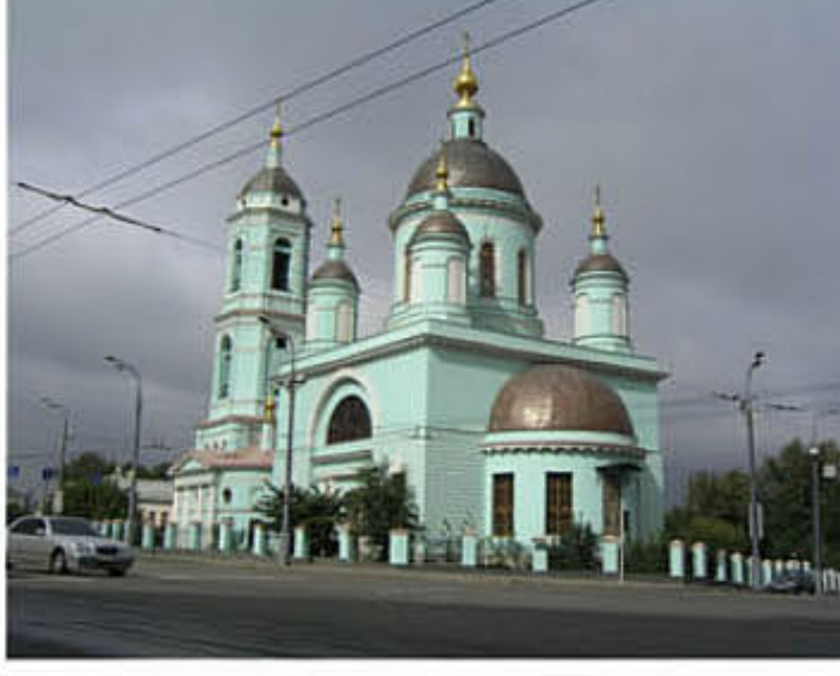
Церковь Сергея Радонежского
